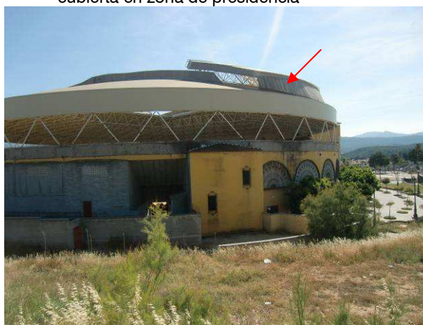
Fotografía nº 14: Vista exterior de la cubierta. Sector móvil
