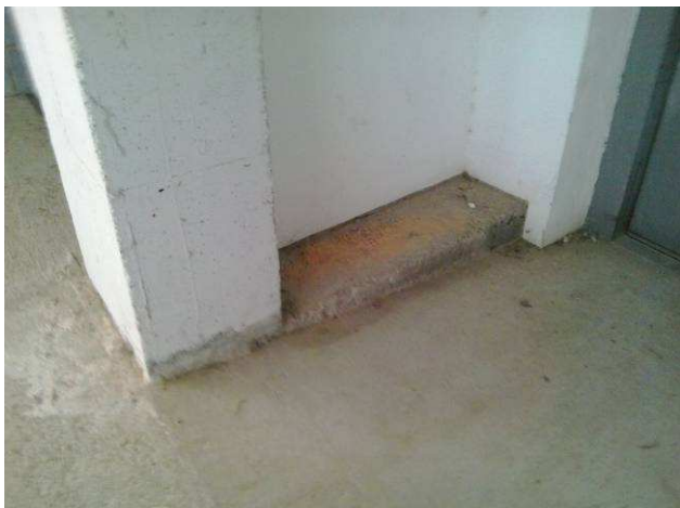
Fotografía nº 65: Pendiente ascendente en salida de ascensor en planta primera.
