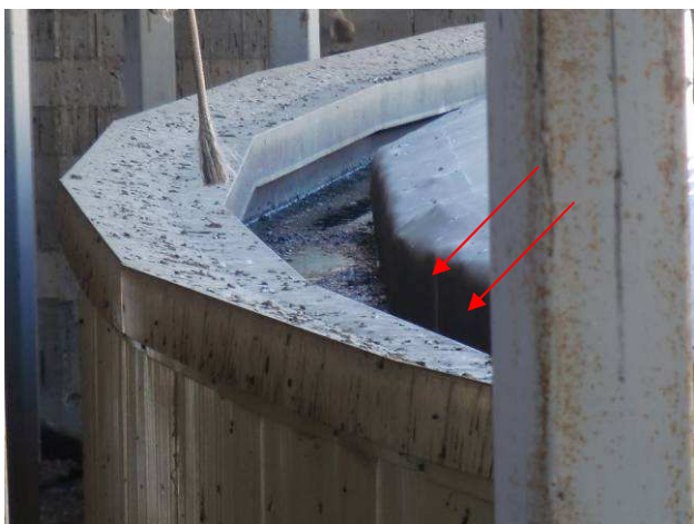
Fotografía nº 27: Canalón de evacuación de cubierta junto a zona de presidencia.
