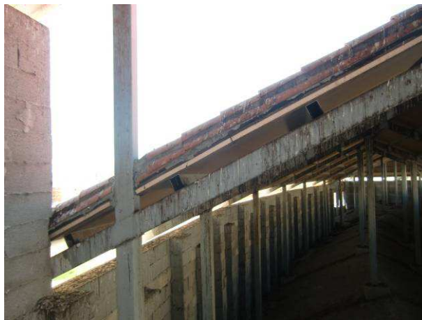
Fotografía nº 16: Vista interior. Solución de cubierta inclinada.
