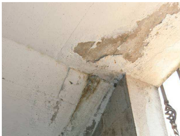
Fotografía n° 94: Zona de dintel de ventana afectado por eflorescencias. Desprendimiento de pintura
