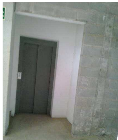
Fotografía nº 66: Ascensor en planta primera.
