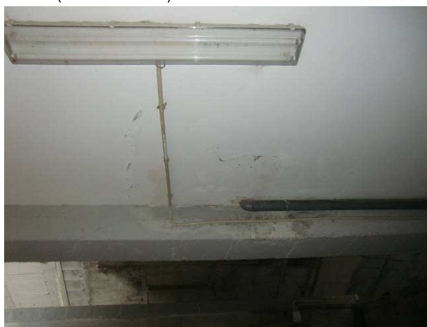
Fotografía nº 102: Humedad por filtración en saneamiento
