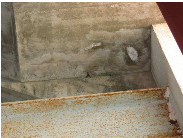
Fotografía nº 88: Superficie de hormigón afectados por eflorescencias
