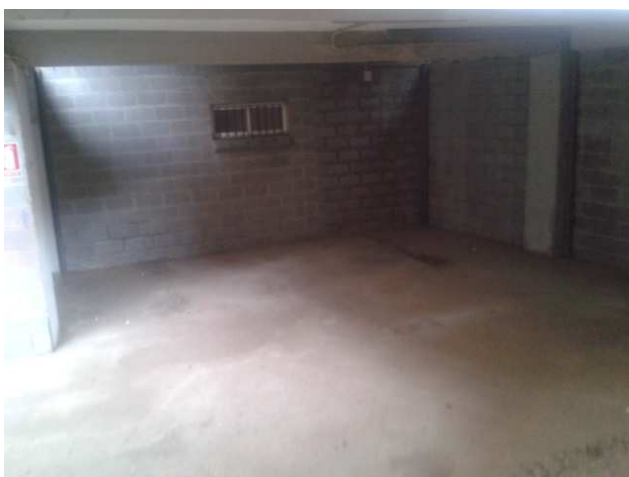
Fotografía nº 57: Tendido 6-8 planta baja
