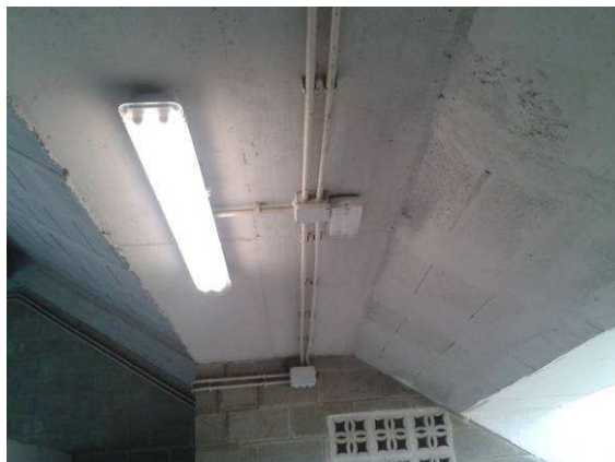
Fotografía nº 74: Detalle de ubicación de alumbrado de emergencia en entrada a graderío
