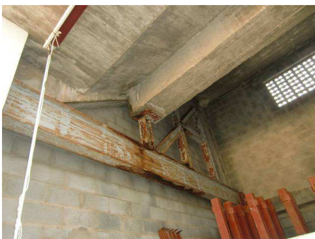
Fotografía nº 25: Oxidación de perfiles en zona de Tendido 9
