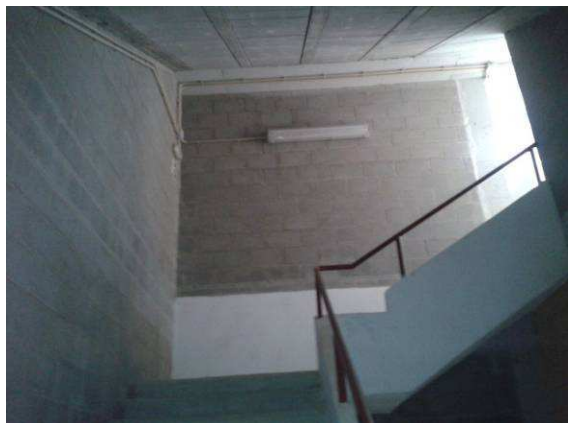
Fotografía nº 73: Detalle de alumbrado de emergencia en escalera
