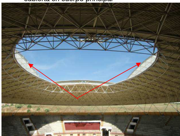
Fotografía nº 13: Vista interior de la cubierta. Sectores móviles
