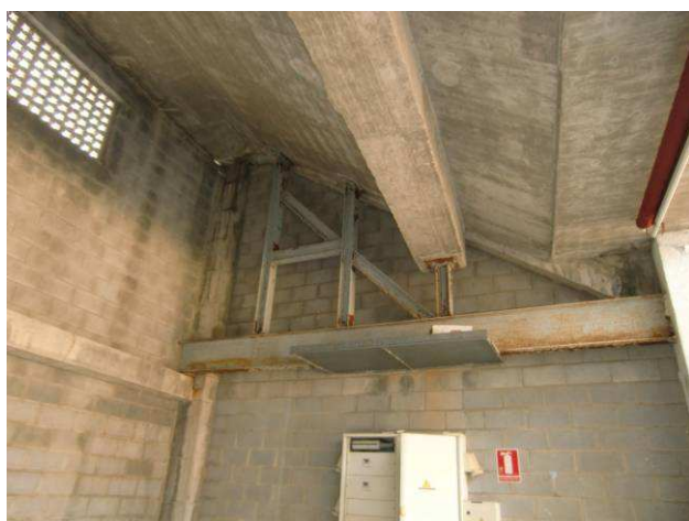
Fotografía nº 26: Oxidación de perfiles en zona de Tendido 9
