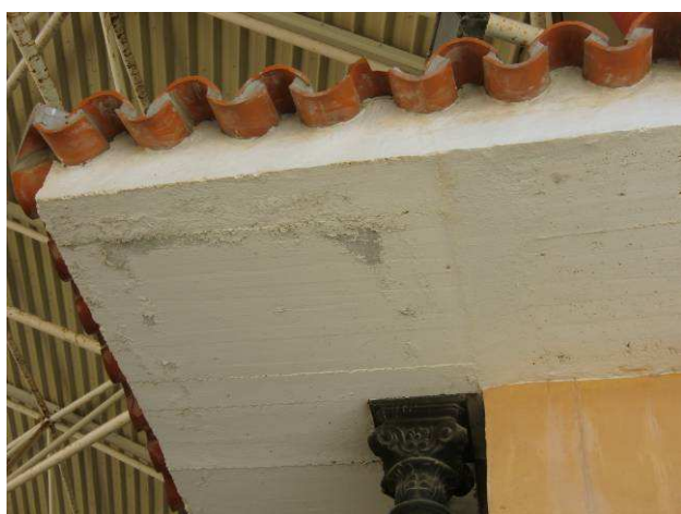
Fotografía nº 93: Zona inferior de voladizo afectado por eflorescencias. Desprendimiento de pintura
