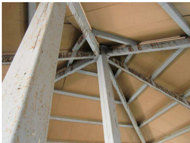
Fotografía nº 24: Oxidación de perfiles en zona de ampliación fachada principal
