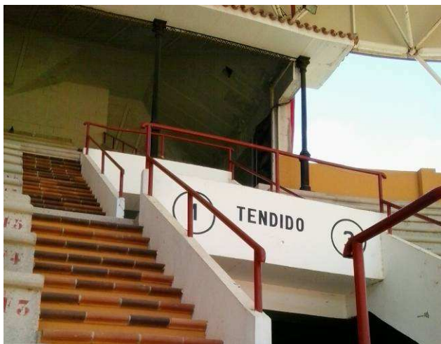
Fotografía n.º 56: Bocel existente en escaleras.
