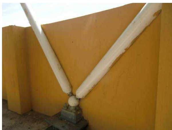
Fotografía nº 48: Perfil tubular empotrado en toda su longitud en cerramiento de bloque
