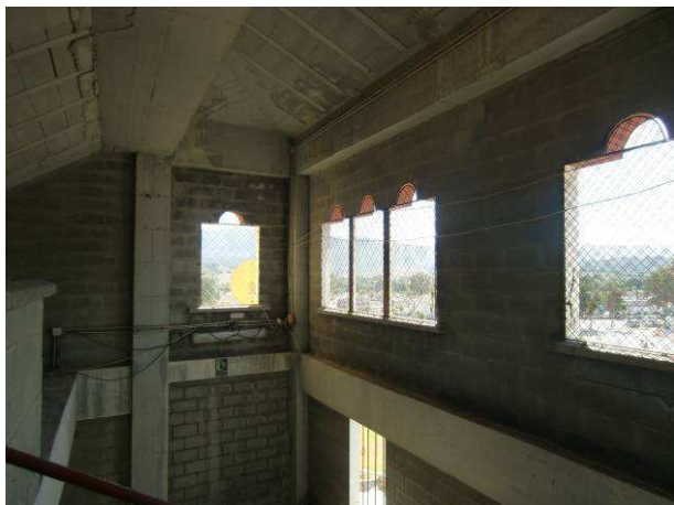
Fotografía nº 9: Vista interior. Estructura de hormigón
