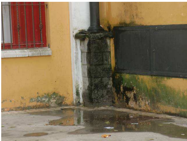
Fotografía nº 95: Deterioro en zona exterior del edificio
