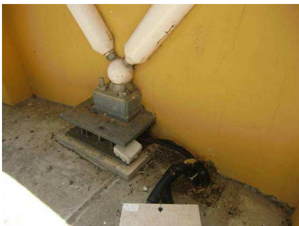
Fotografía nº 49: Detalle de apoyo de perfiles tubulares empotrado en toda su longitud en cerramiento de bloque
