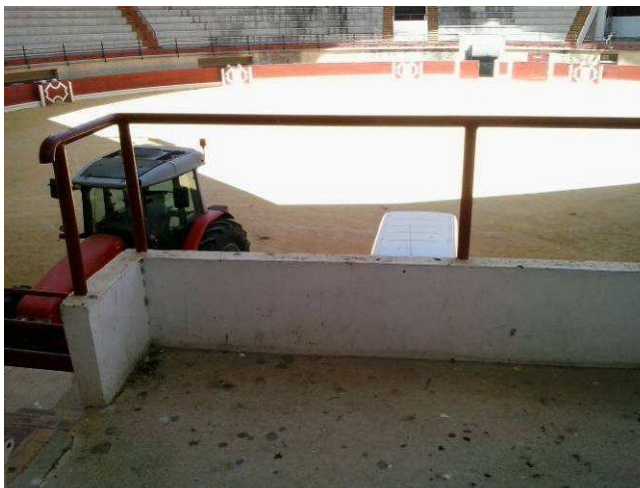
Fotografía nº 52: Barandilla existente en salida a tendido.
