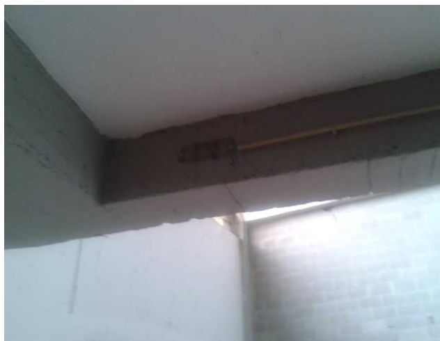
Fotografía nº 60: Tendido 6-8 planta baja.
