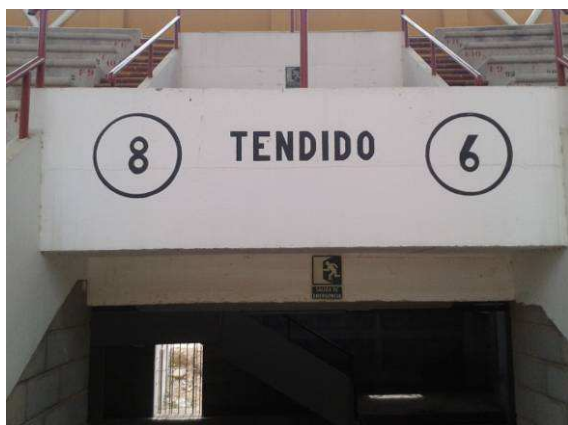
Fotografía nº 69: Tendido 6-8 donde se ha decidido colocar grupo electrógeno
