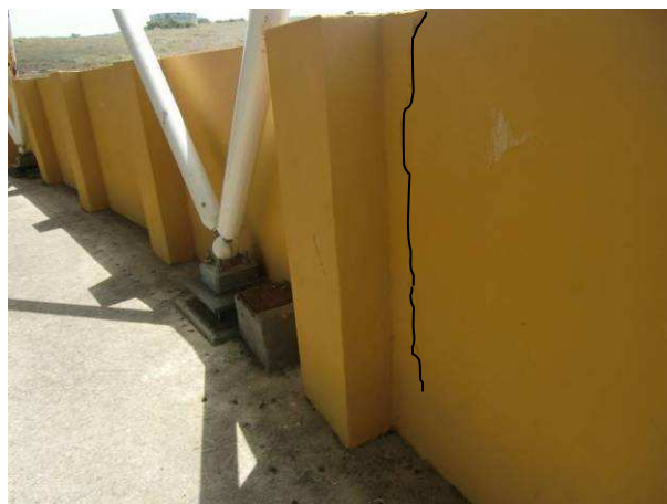
Fotografía nº 44: Fisura vertical junto a pilastra
