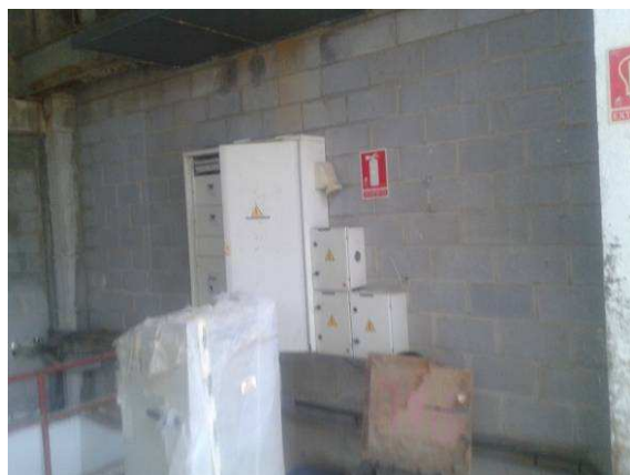
Fotografía nº 81: Cuadro general situado en tendido 9 (Escenario) Junto a escalera
