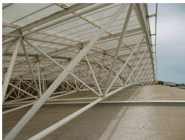
Fotografía nº 36: Vista general de cubierta
