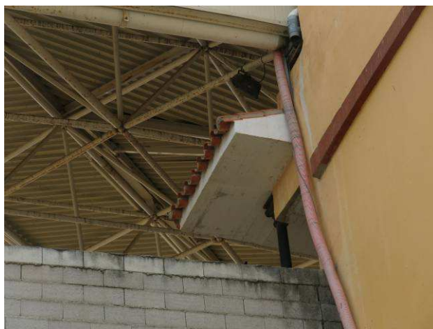
Fotografía nº 34: Evacuación directa en cubierta
