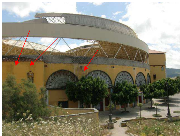
Fotografía nº 96: Deterioros en revestimiento
