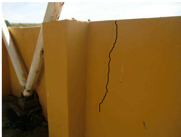
Fotografía nº 46: Fisura junto a pilastra
