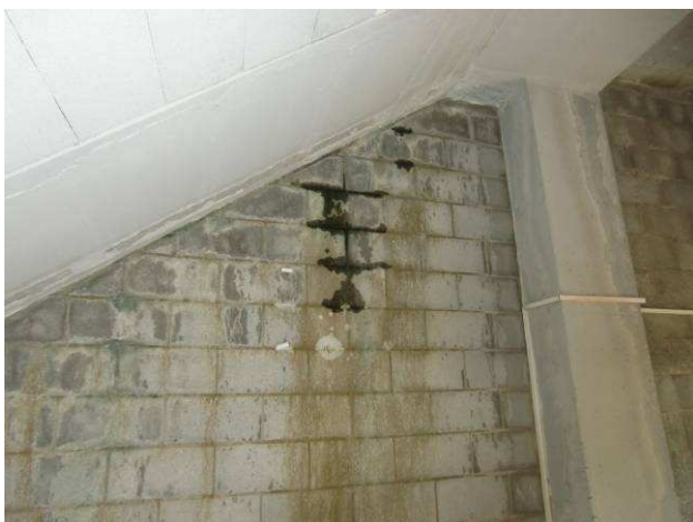
Fotografía nº 99: Humedad por filtración en junta estructural
