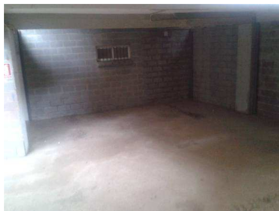
Fotografía nº 70: Detalle de ubicación de Grupo Electrógeno (Tendido 6-8 planta baja, junto a los baños)
