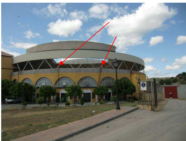
Fotografía nº 31: Vista general de plaza de toros. Se observa sistema de evacuación provisional.
