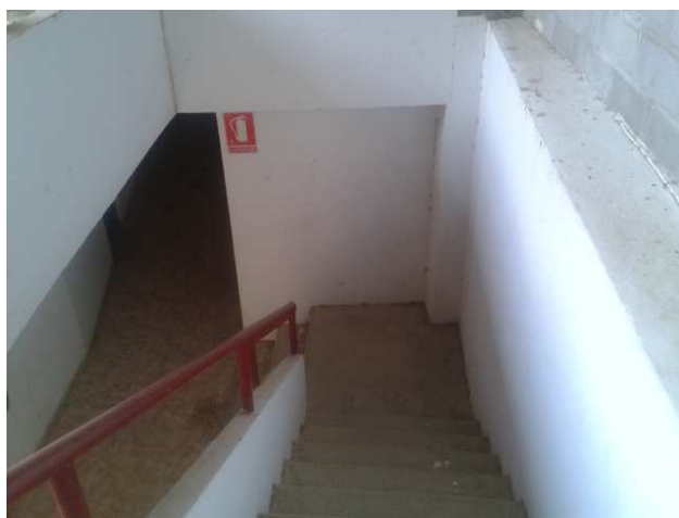
Fotografía nº 58: Escalera de comunicación a escenario en tendido 9
