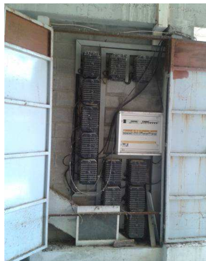
Fotografía nº 80: Cuadros secundarios en gradas de presidencia, tendido 1-3 Nivel +16.10 m.
