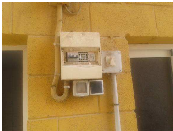
Fotografía nº 82: Cuadro secundario de alumbrado en puerta de cuadrilla
