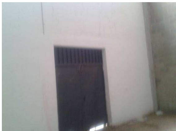
Fotografía nº 77: Puerta de evacuación o emergencia en tendido 5-7
