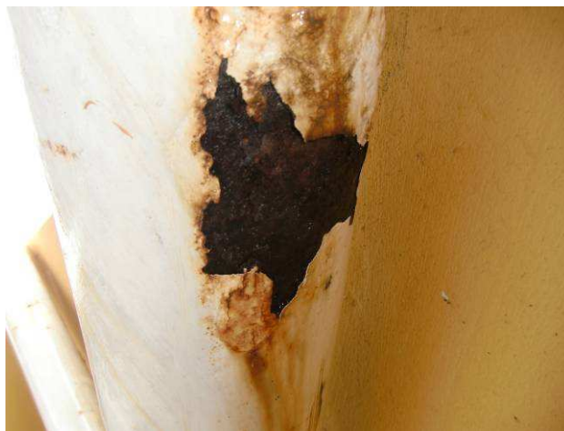
Fotografía nº 20: Oxidación de perfil tubular con pérdida de material de protección
