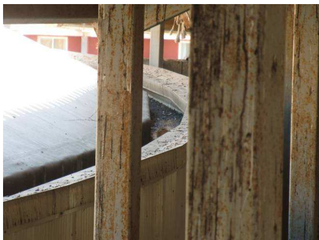
Fotografía nº 28: Canalón de evacuación de cubierta junto a zona de presidencia.
