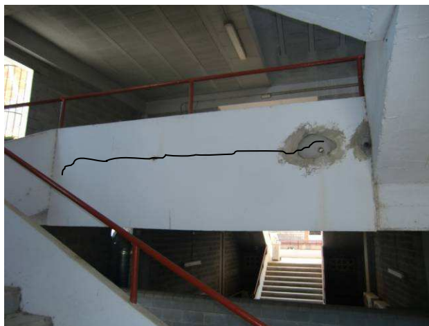
Fotografía nº 87: Fisura en revestimiento en zona canto de forjado
