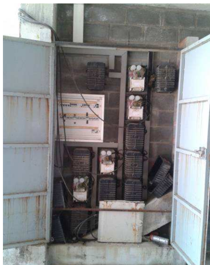
Fotografía nº 79: Cuadros secundarios en gradas de presidencia, tendido 2-4 Nivel +16.10 m.
