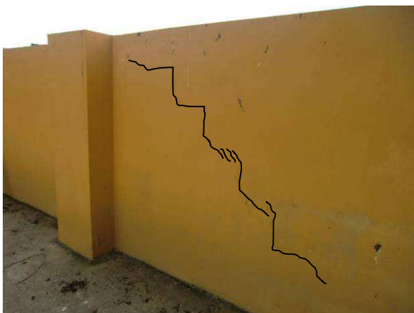
Fotografía nº 43: Fisura oblicua en zona de pilastra
