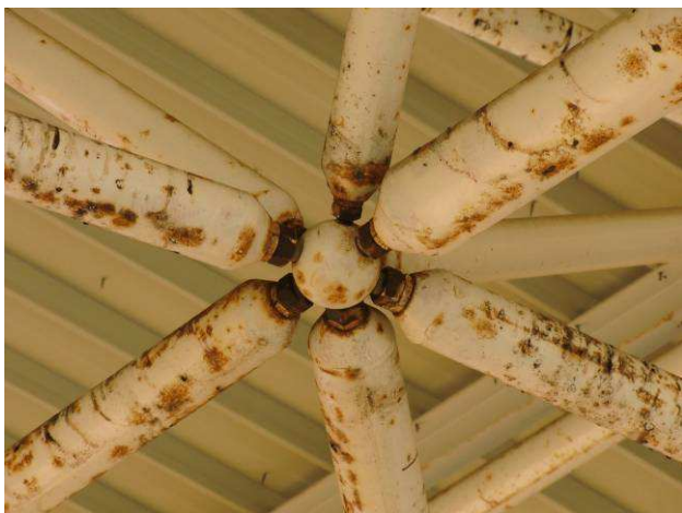
Fotografía nº 23: Oxidación de perfiles tubulares y nudos esféricos
