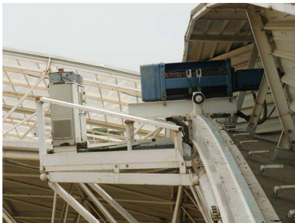
Fotografía nº 41: Puesto de control
