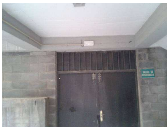
Fotografía nº 76: Detalle de ubicación de alumbrado de emergencia en puerta de emergencia.
