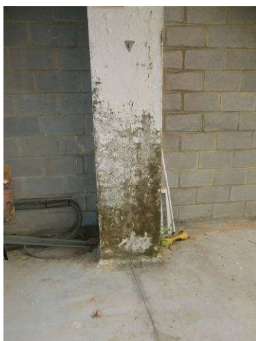
Fotografía nº 101: Humedad en zona de Tendido 9
