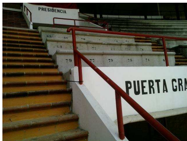
Fotografía nº 54: Barandilla existente en salida a tendido.
