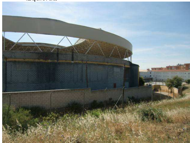
Fotografía nº 4: Vista exterior. Fachada trasera
