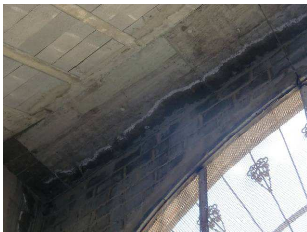
Fotografía nº 89: Superficie de hormigón afectados por eflorescencias
