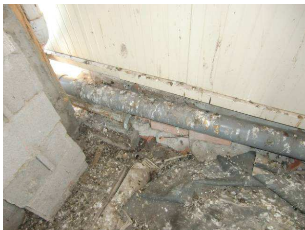
Fotografía nº 30: Conducto de PVC para evacuación de agua
