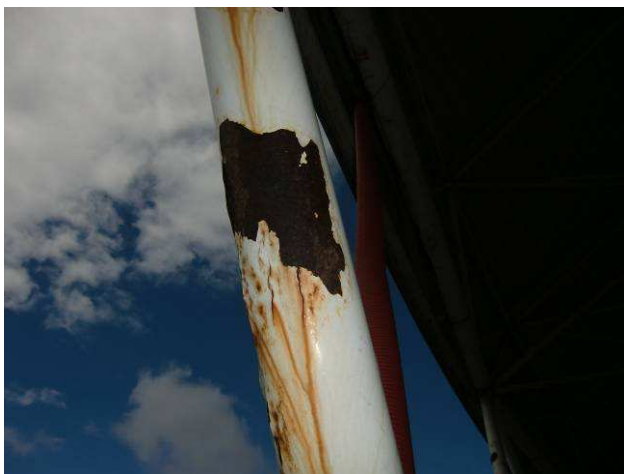
Fotografía nº 19: Oxidación de perfil tubular con pérdida de material de protección
