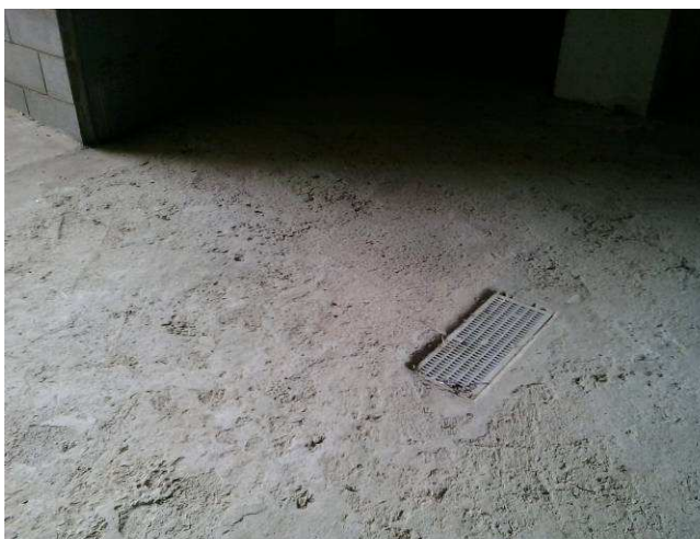
Fotografía nº 67: rejilla para recogida de aguas pluviales.
