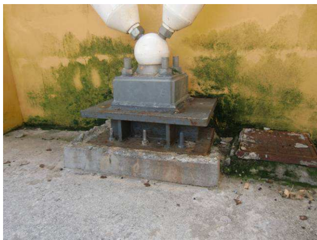
Fotografía nº 98: Humedad por filtración
