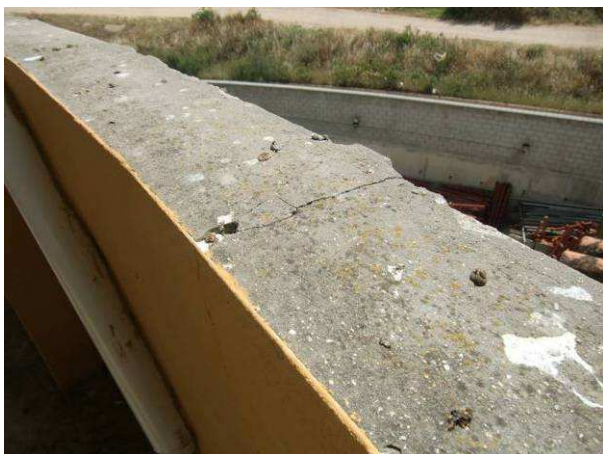
Fotografía nº 45: Fisura que atraviesa cerramiento
