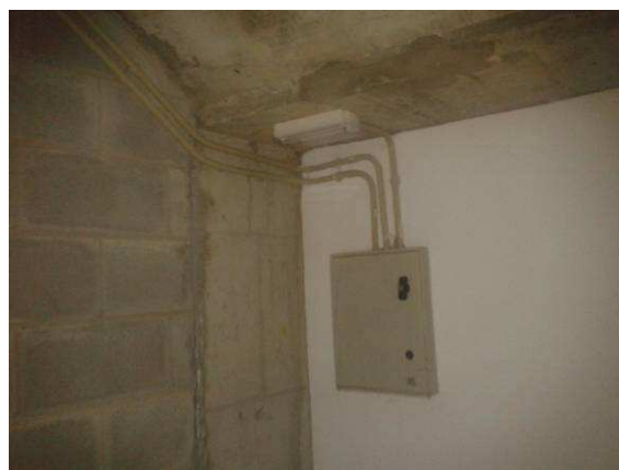
Fotografía nº 84: Cuadros secundarios de alumbrado de escaleras en planta baja tendido 2-4
