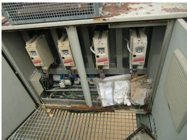
Fotografía nº 39: Cuadro de control
