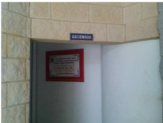
Fotografía nº 71: Detalle de entrada ascensor en planta baja
