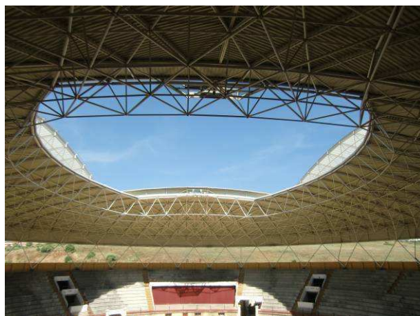
Fotografía nº 6: Vista interior. Cubierta
