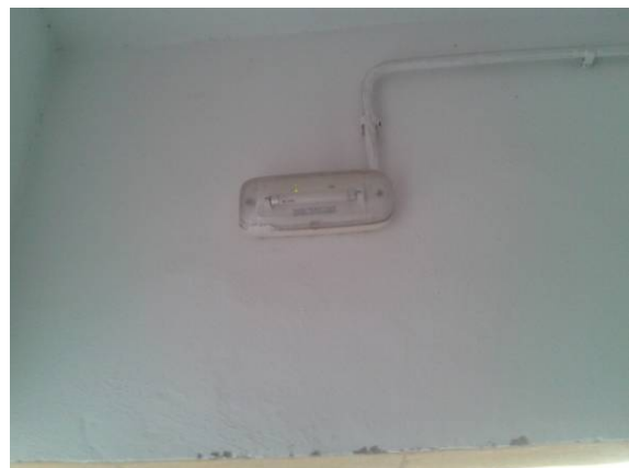
Fotografía nº 72: Detalle de ubicación de alumbrado de emergencia de ascensor en planta baja
