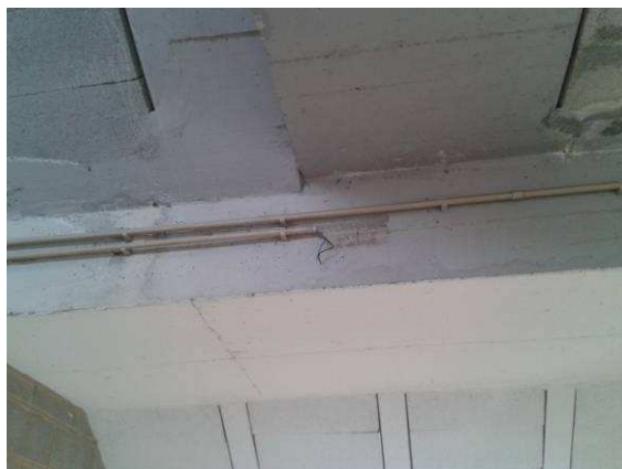
Fotografía nº 78: Detalle zona de reposición de luminaria
