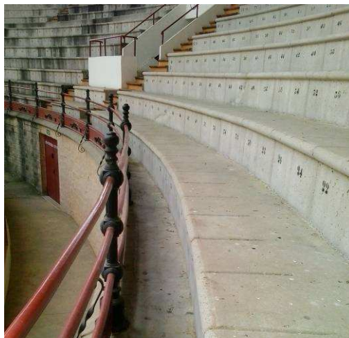
Fotografía nº 53: Barandilla existente en graderío en fila 1.
