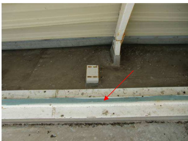
Fotografía nº 35: Rail sin arañazos
