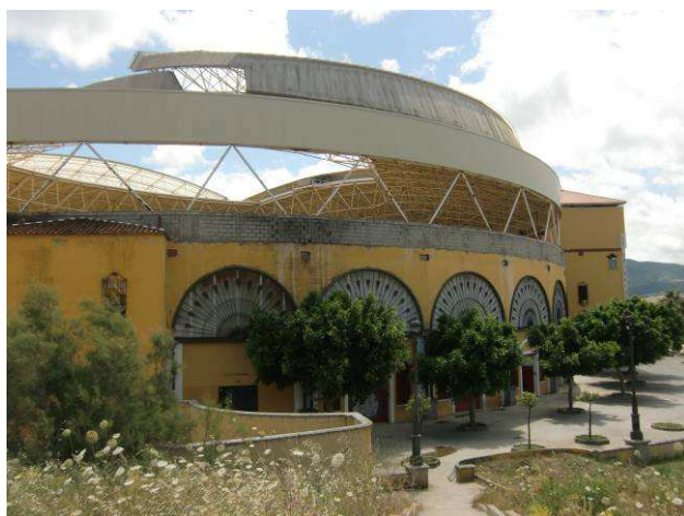
Fotografía nº 32: Vista general de plaza de toros. Se observa sistema de evacuación provisional.
