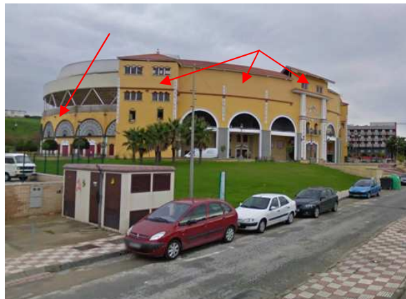
Fotografía nº 10: Vista exterior. Zona ampliada de fachada principal y cerramiento de cuerpo principal
