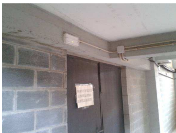
Fotografía nº 75: Detalle de ubicación de alumbrado de emergencia en puerta de emergencia
