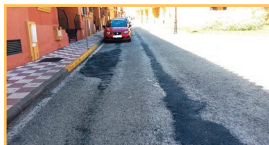
Arreglo baches en Las Perenholas
