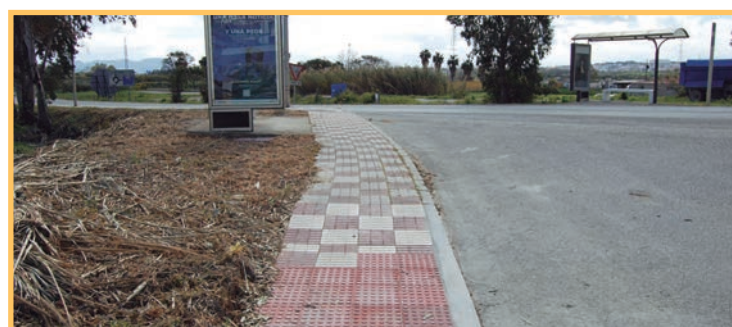
Reparación Acerado de carretera 440
