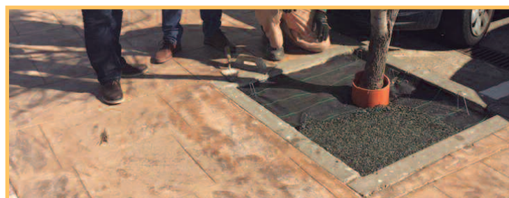
Instalación de alcorques rellenos
