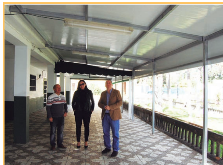
Los Cortijillos ya disfruta de la nueva marquesina del Edificio Multiusos
