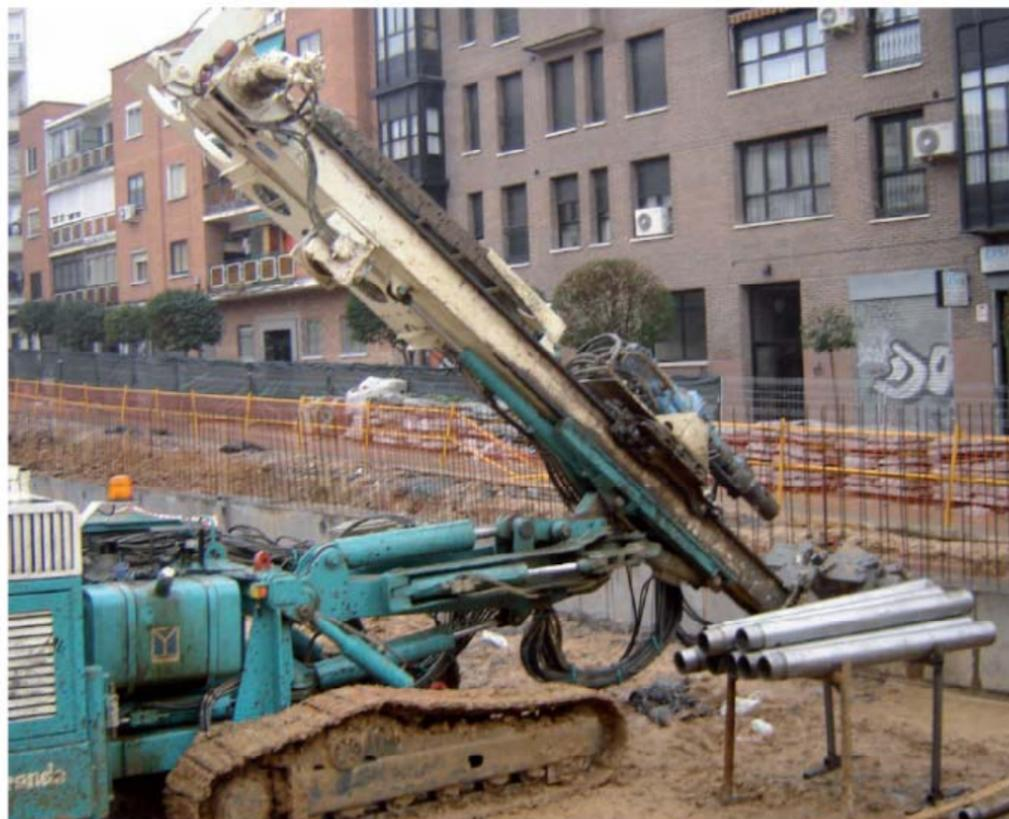
Equipo de perforación y utillaje en borriquetas.
