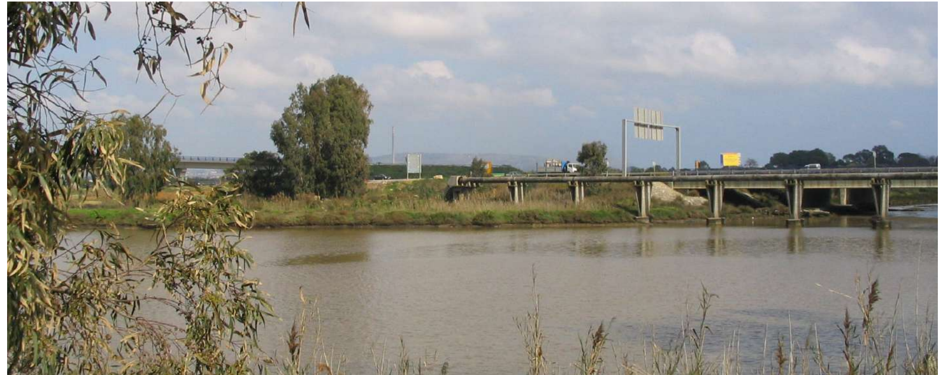
Cauce del río Palmones.
