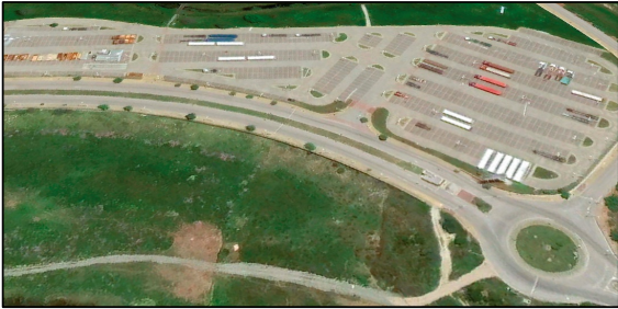
Ilustración 6. Vial 1, zona ubicación nuevas rotondas
