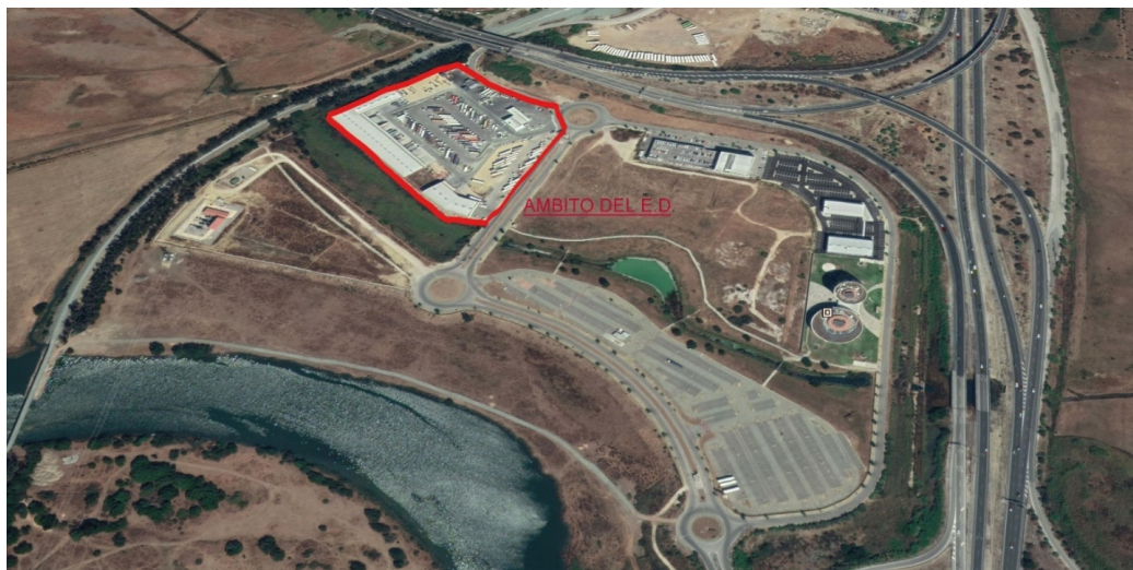
Ilustración 1. Sector El Fresno. Situación CSC-1. Ámbito E.D.
