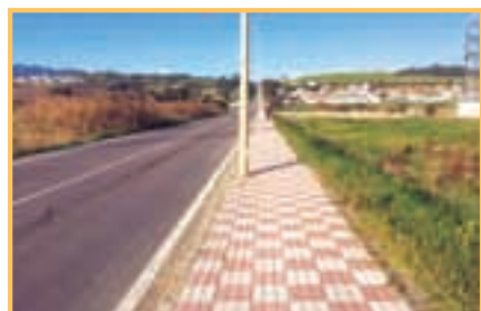
Nuevo acerado en Puente Romano
