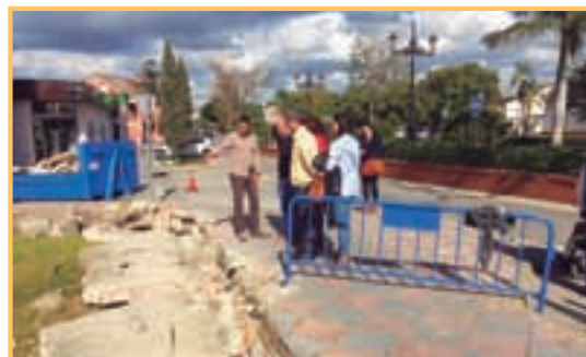
Obras de la reforma integral de la avenida Tercer Centenario
